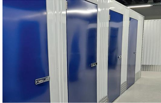
**PROFIL-TÜR.** Diese Profil-Tür besteht aus Trapezblechplatten, die in einem umlaufenden Rahmen eingefasst ist und durch innenseitige Kreuzverstrebrungen stabilisiert wird. Die Tür ist kratzfest pulverbeschichtet und in fast allen RAL Farben erhältlich.
